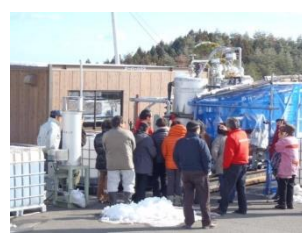
バイオガス発生試験
