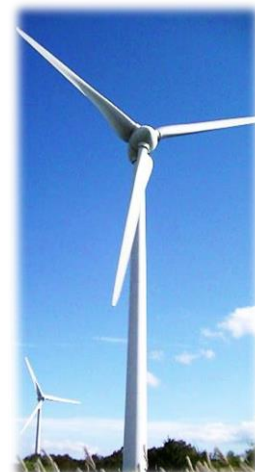
風力発電装置 風車直径 71m 風車中心高 64m
